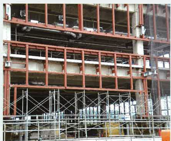
先行耐火工法施工例
